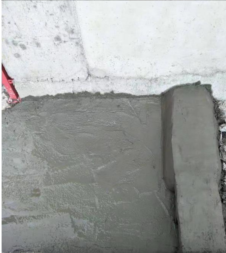
连通事故排水系统管道，并对管道所在地面实施硬化
