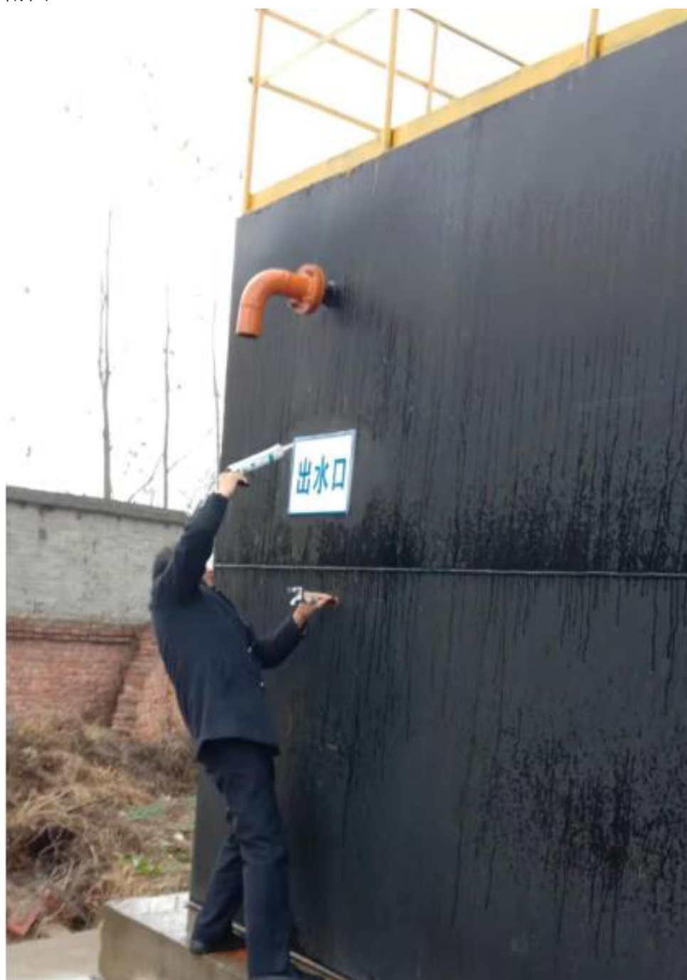
安装水污染治理设施标志牌
